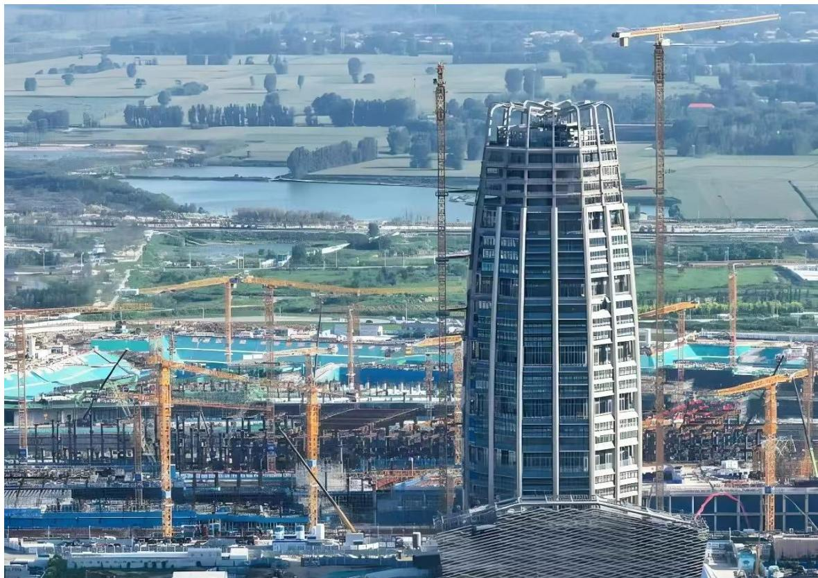
中国中化大厦是首批疏解央企中国中化的总部大楼，设计结构高度 150 米，地上 30 层，总建筑面积 11.49 万平方米。历经 3 年建设，如今初露真容，正在进行内部精装修，即将迎来交付验收的重要
